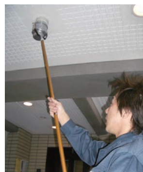
消防法定点検
