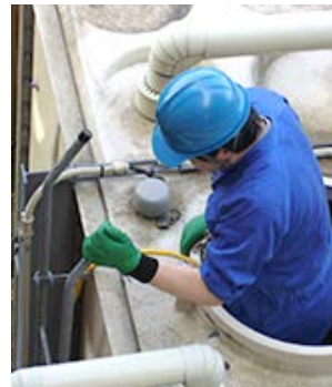
貯水槽・排水管清掃
